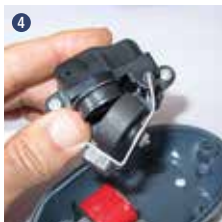
Membraan van de luchtkamer verwijderen
